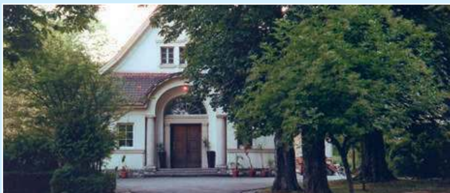
Der Firmensitz – das frühere Wasserwerk von Münster-Sarmsheim
